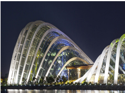
35. Imágenes superiores: detalle del sombreamiento de la cubierta
