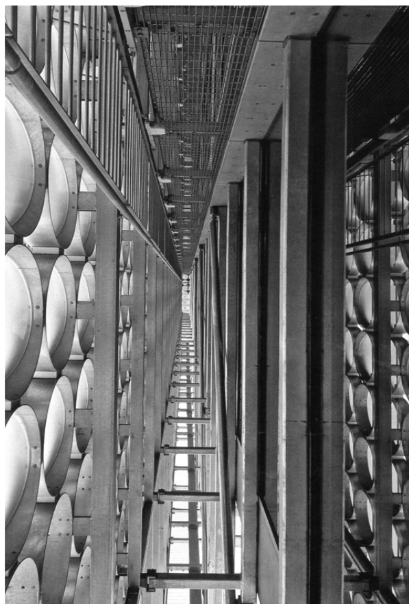
61. Imagen de la cámara de gas argón entre la doble fa-
