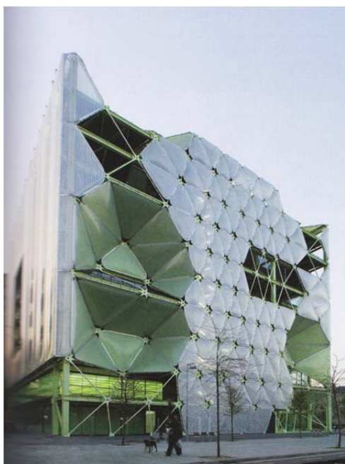
63. Derecha: detalle fachada sureste de EFTE
