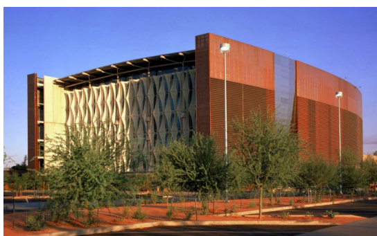
28. Izquierda: imagen exterior de la librería de Phoenix, Estados Unidos (1995) 29. Derecha: detalle de las telas pretensadas de la fachada norte en la librería de Phoenix
