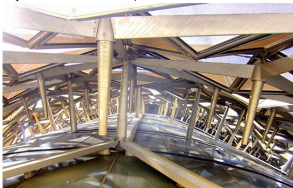
58. Detalle de la cámara © Arup
