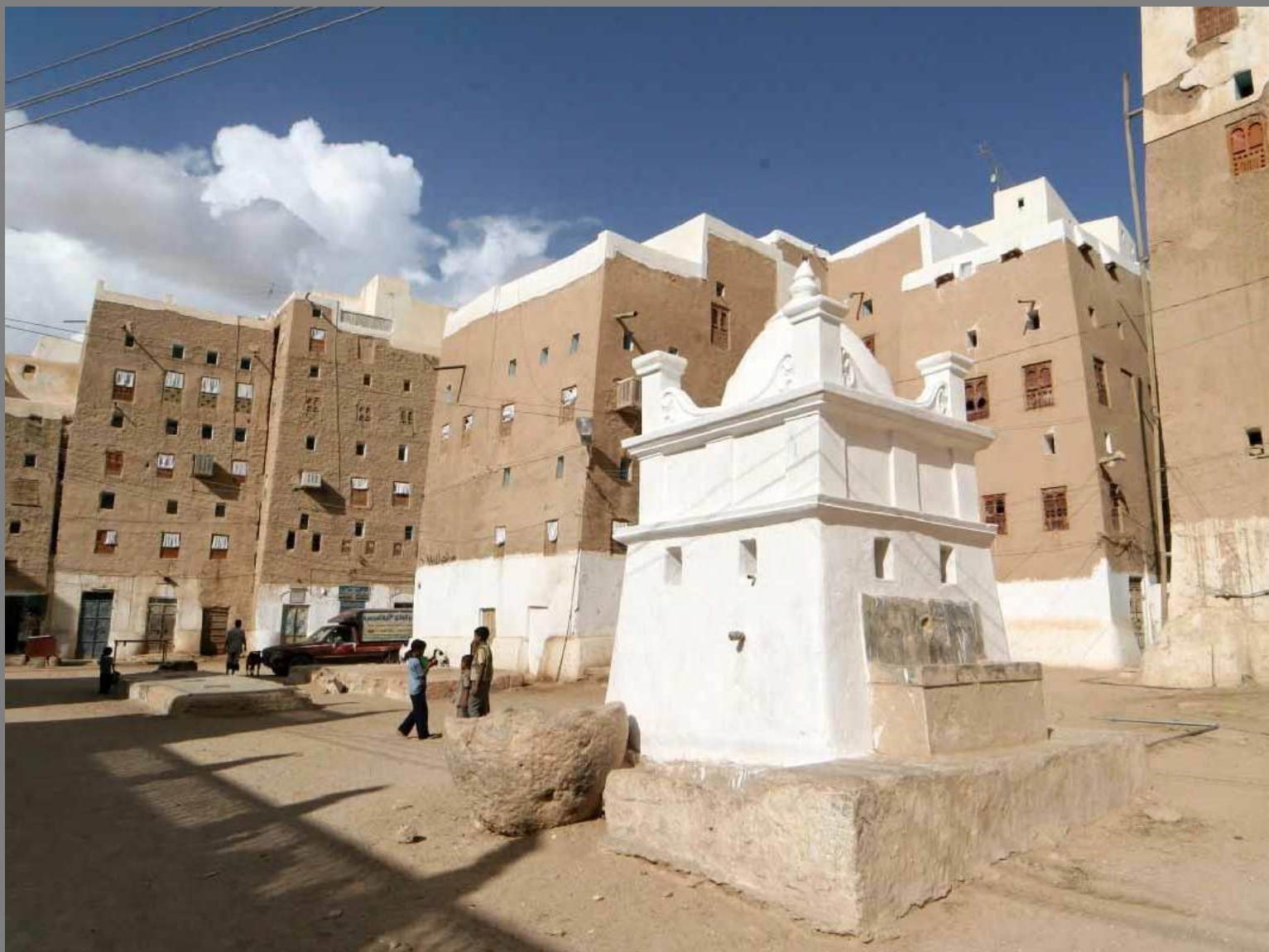
Ciudad de Shibam (Yemen) ya existía en el siglo III
