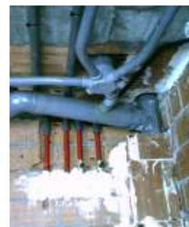
Figura IV.2.5. Rozas no retacadas, ocultas tras un falso techo
