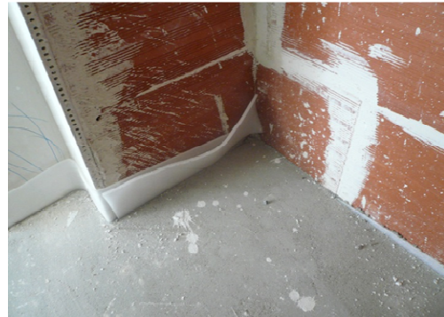
Figura IV.2.14. Lámina aislante a ruido de impactos que no sobresale en el encuentro con la partición, dando lugar a un contacto rígido entre el suelo y las paredes.
