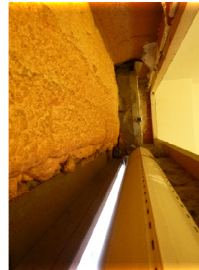
Figura IV.2.2. Interior de un capialzado. Puede verse la holgura excesiva de la persiana.
