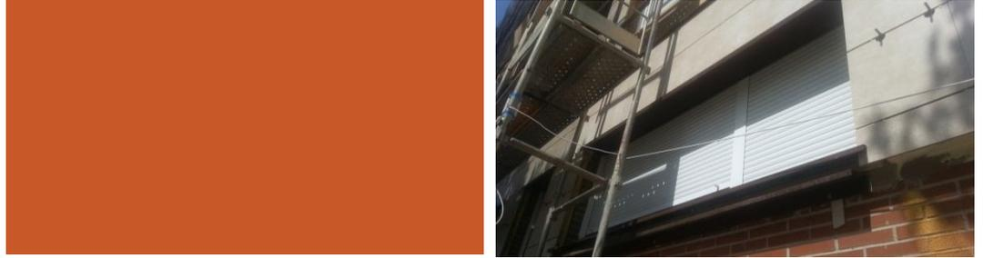
Se ha puesto especial cuidado en la resolución de los recercados y jambeados de las ventanas para minimizar los puentes térmicos y las infiltraciones de aire.
