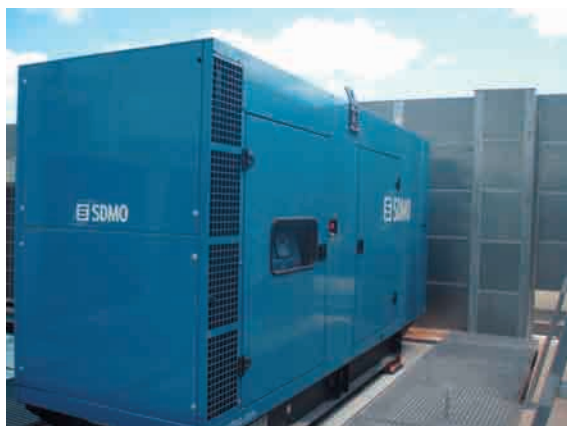
Figura 10. Ejemplo de grupo electrógeno.
