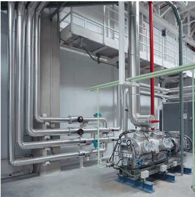
Figura 1. Instalaciones (Cortesía AhorraMás).
