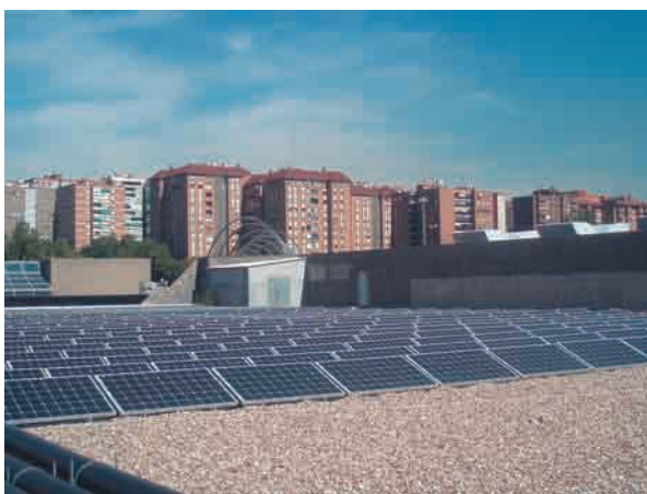
Figura 12. Instalación fotovoltaica en el supermercado La Vaguada.
