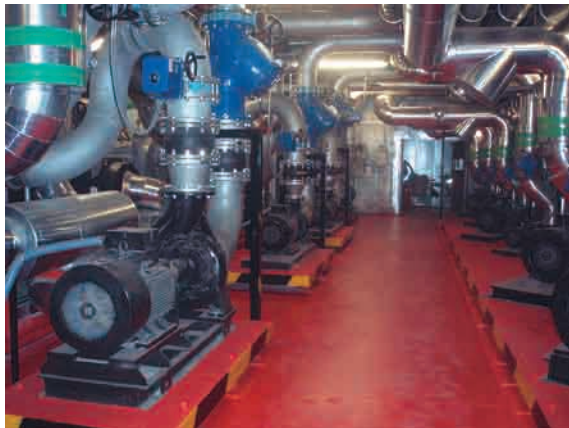
Figura 8. Grupos frigoríficos instalados en el La Vaguada.
