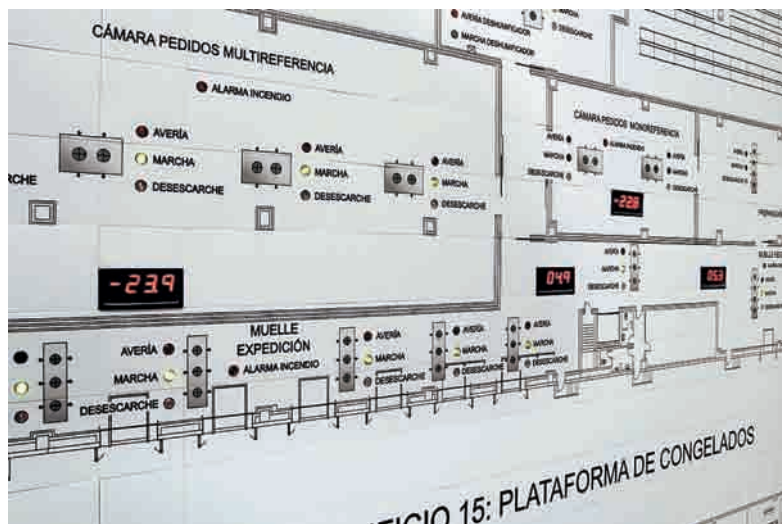
Figura 3. Cuadro de control de las instalaciones (Cortesía AhorraMás).
