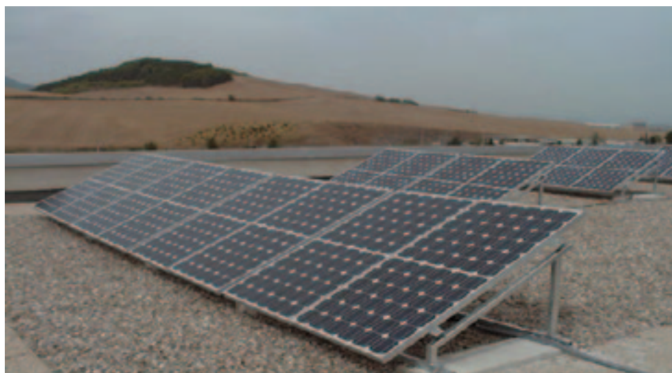
Foto 4. Sistema fotovoltaico sobre tejado plano.
