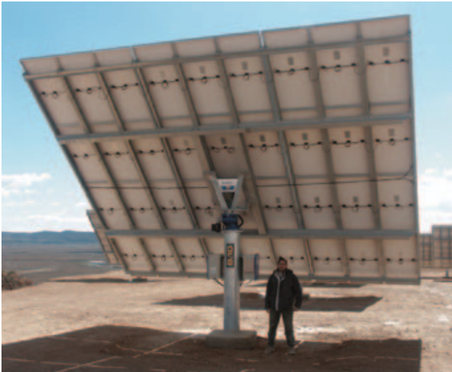
Foto 5. Instalación fotovoltaica sobre seguidor solar.
