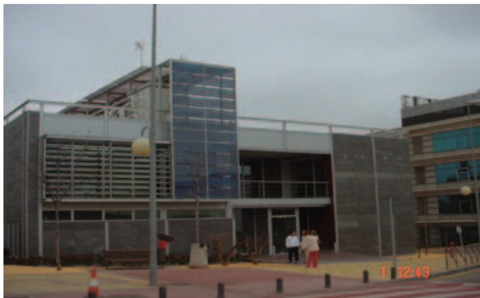
Foto 6. Instalación fotovoltaica integrada en muro cortina.
