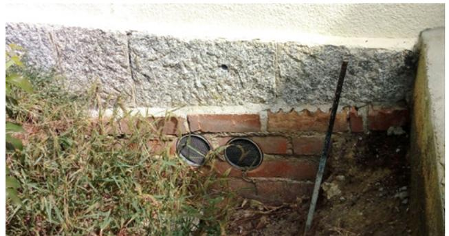
Figura 7 - Aberturas de ventilación finalizadas con rejillas
