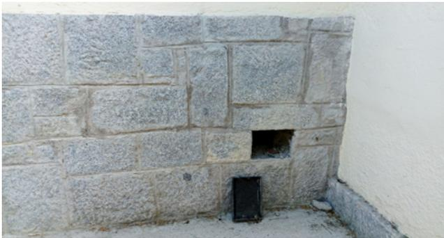
Figura 4 - Abertura de ventilación existente
