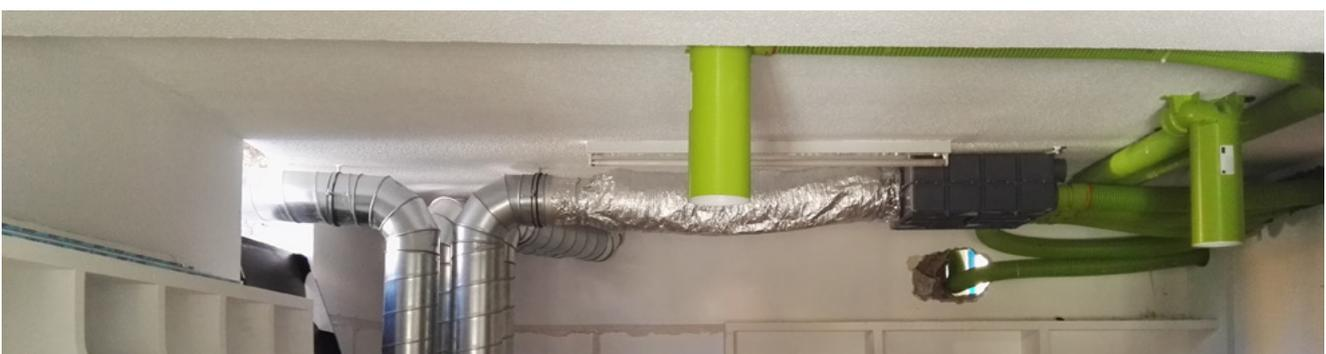
Figura 8 - Red de conductos de impulsión y expulsión
